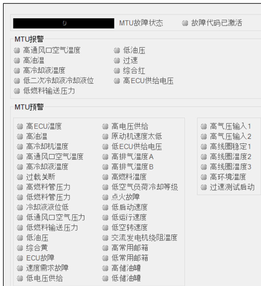
图 4-137. 测量, mtu, mtu 报警
